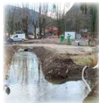
fordert für die Sicherstellung der Aufstiegsmöglichkeiten für Fische eine Absenkung des Bachbettes und damit sind größere Böschungsfächen verbunden. Parallel dazu wird bereits die Brücke der Engleitenstraße über den Kaltenbach neu gebaut. Der zu geringe Durchflussquerschnitt und der schlechte Bauzustand machten hier einen Neubau notwendig.
