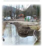
fordert für die Sicherstellung der Aufstiegsmöglichkeiten für Fische eine Absenkung des Bachbettes und damit sind größere Böschungsflächen verbunden. Parallel dazu wird bereits die Brücke der Engleitenstraße über den Kaltenbach neu gebaut. Der zu geringe Durchflussguerschnitt und der schlechte Bauzustand machten hier einen Neubau notwendig.
